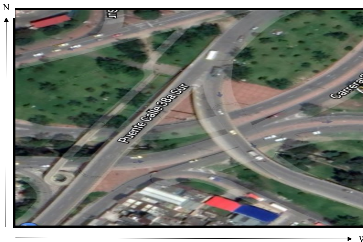
Figura 19. Ubicación puente No.2. Fuente: extraído de (Google Earth, 2020)
