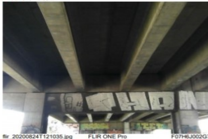
Figura 45. Fotografía No 2 Tablero, apoyos parte inferior del puente. Fuente: propia
