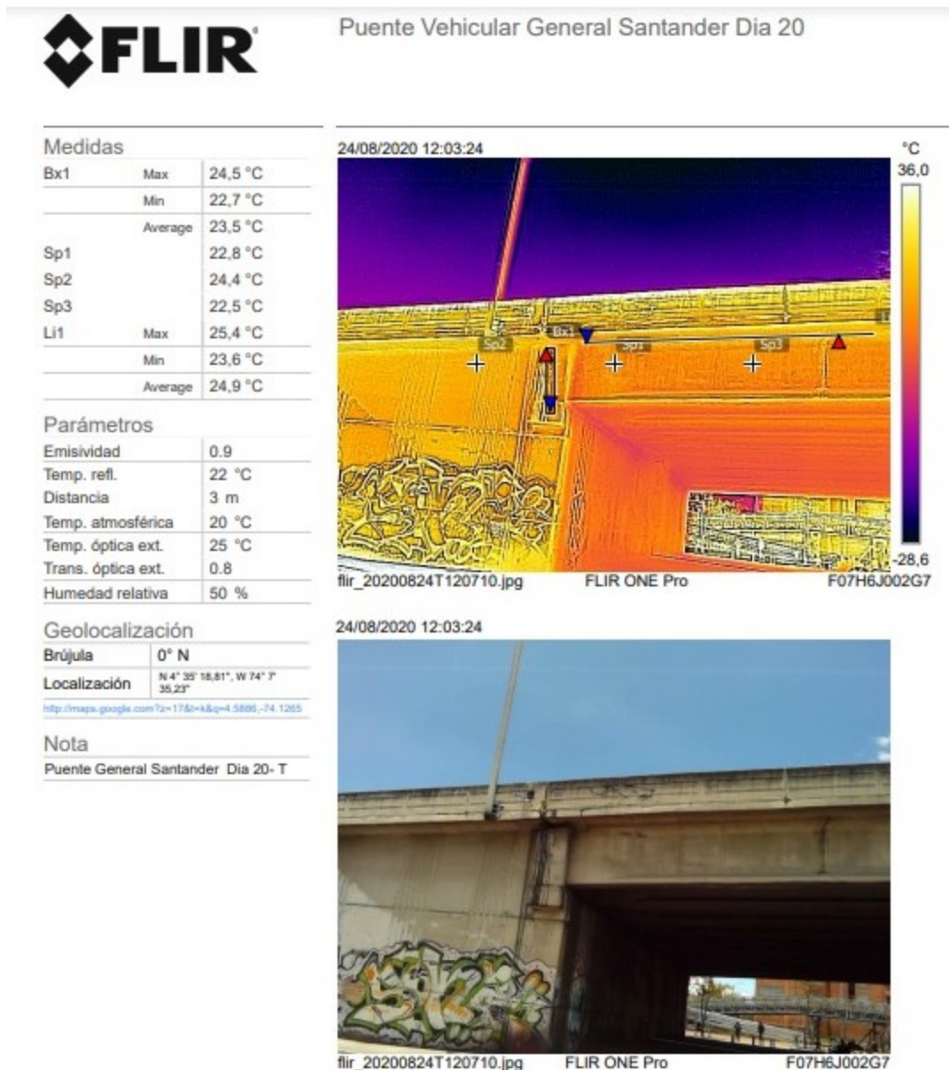
Figura 42. Informe generado para fotografía No 1 - Perfil entrada al puente. Fuente: elaboración propia
