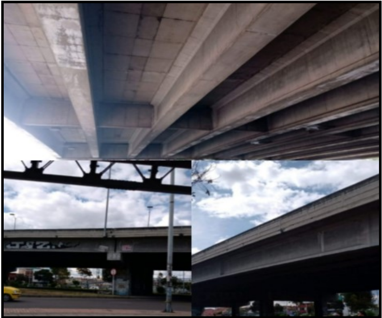
Figura 18. Imágenes puente No. 1. Fuente: Elaboración propia
