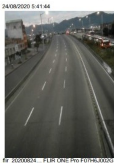
Figura 51. Fotografía No 4 parte superior del puente. Fuente: elaboración propia.
