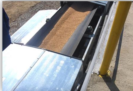
Figura 19: Transportadora mecánica Fuente: (silos córdoba)
