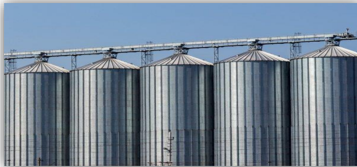
Figura 5: Silos de torre metálicos Fuente: (Deposit)
