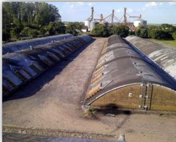
Figura 14: Silos subterráneos permanentes Fuente: (Agroads)
