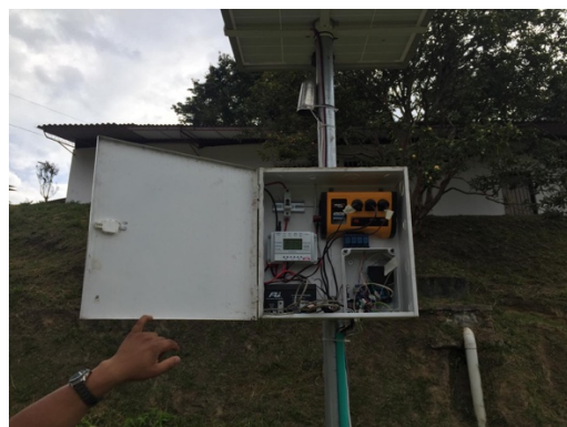
Fig. 5.1 Sistema fotovoltaico autónomo de riego por goteo
