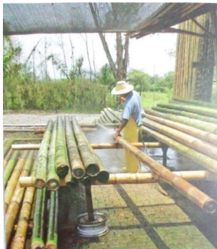
Figura 1-16. Limpieza superficie de la guadua
