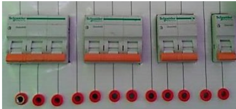
Figura 2-14: Breakers trifásicos, bifásicos y monofásicos.
