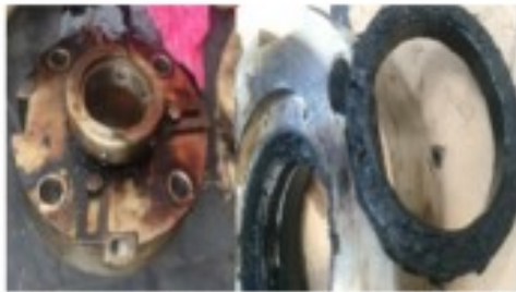
Figura 13. Inspección de sello mecánico. Izquierda, sello mecánico con evidencia de fuga. Derecha, componentes internos con material solidificado.
