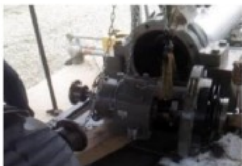
Figura 9. Desmontaje de bomba OH2 para cambio de sello mecánico.
