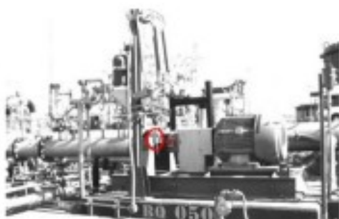
Figura 21. Ubicación de punto de máxima vibración en el plan 53B.
