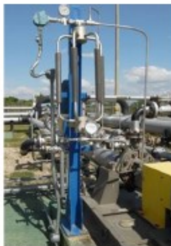
Figura 11. Instalación del plan 53B.
