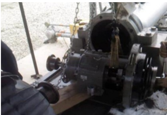
Figura 9. Desmonte de bomba OH2 para cambio de sello mecánico.
