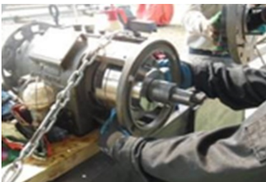
Figura 10. Cambio de sello mecánico en la bomba OH2.
