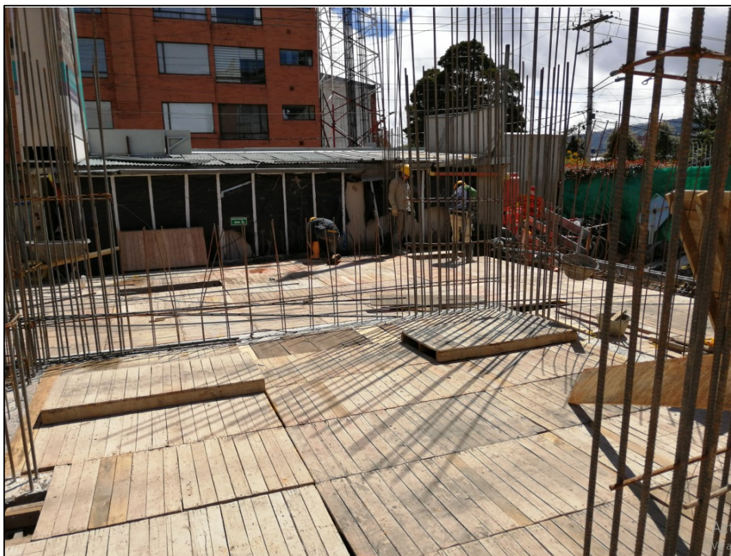
Figura 13. Instalación de Testeros en Madera
