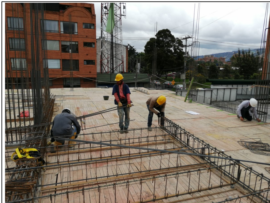
Figura 9. Armado de Hierro y Vigas
