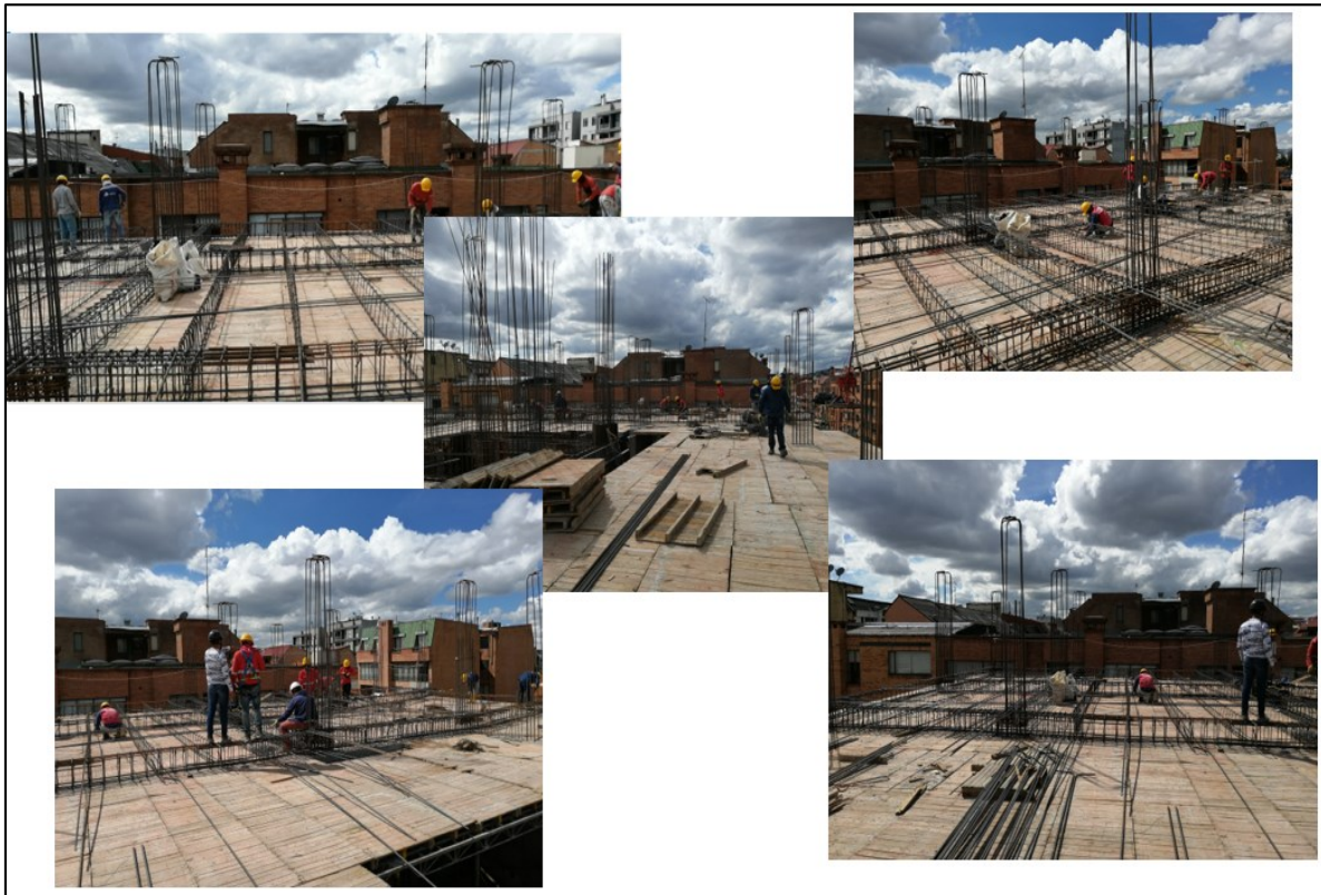
Figura 10. Armado de Hierro y Vigas
