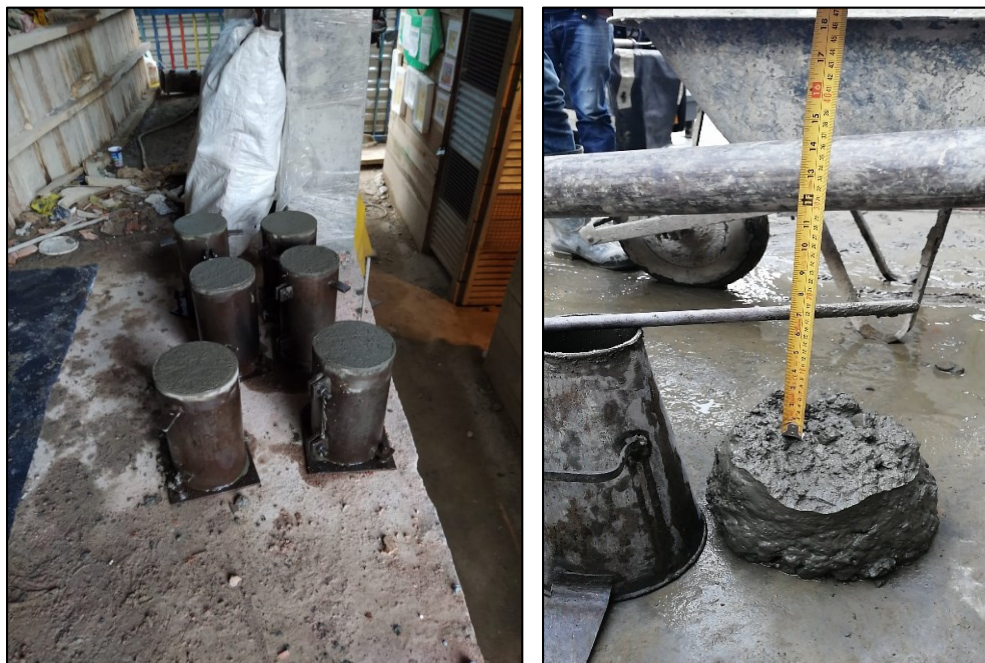
Figura 14. Toma de Muestras de Concreto
