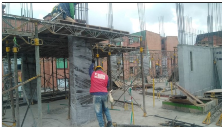
Figura 8. Verificación del Armado de Entrepiso
