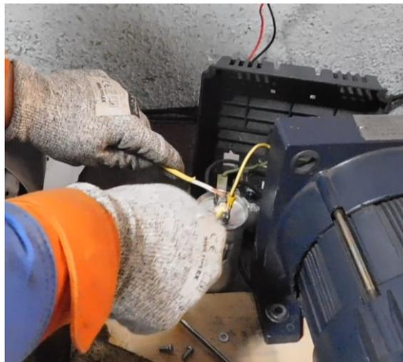
*Figura 88. Momento exacto en donde se realiza la recarga del condensador mediante una corriente alterna externa. [Fuente propia]*
