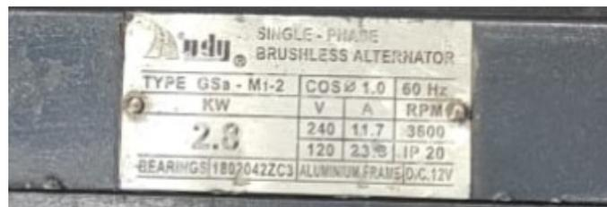
Figura 30. Placa de características del generador monofásico que se usó. [Fuente propia]
