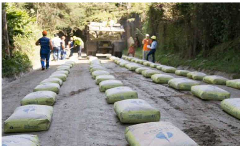
Figura 2. Estabilización con cementó (Cementos argos, 2017)
