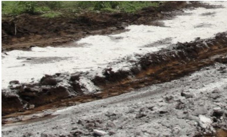
Figura 1. Estabilización con cal (prefanicsa 2014)
