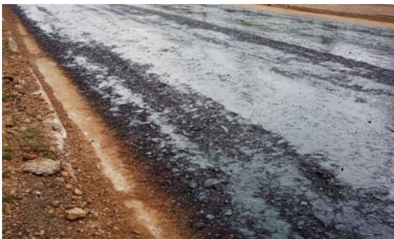
Figura 4. Estabilización con asfalto (Vía Julio Delgado Uruguay,2019)
