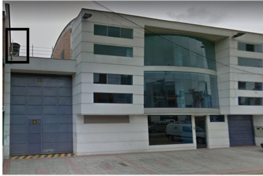
Figura 13. ubicación del tanque de reserva. Google maps 2020.
