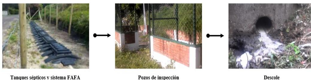
Figura 10 Esquema de funcionamiento del Sistema de Tratamiento de Aguas Residuales (STAR) La Yerbabuena. .
