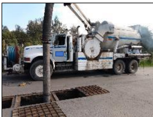
Ilustración 33: Drenado de trampas de grasa. Fuente: el autor.
