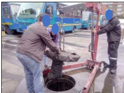
Ilustración 34: protección de sumideros de agua lluvia. Fuente: el autor.
