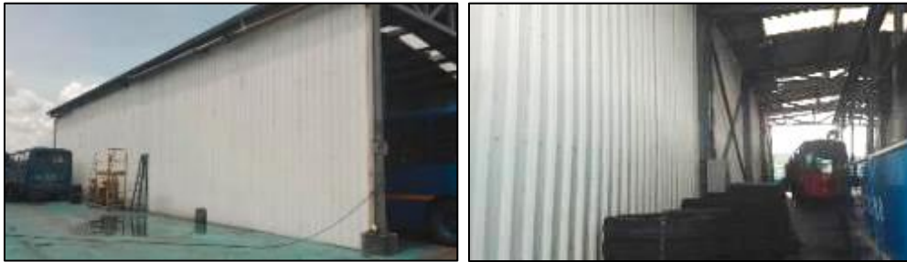
Ilustración 16: Insonorización de zona para intervención de llantas (mantenimiento neumático). Fuente: el autor.
