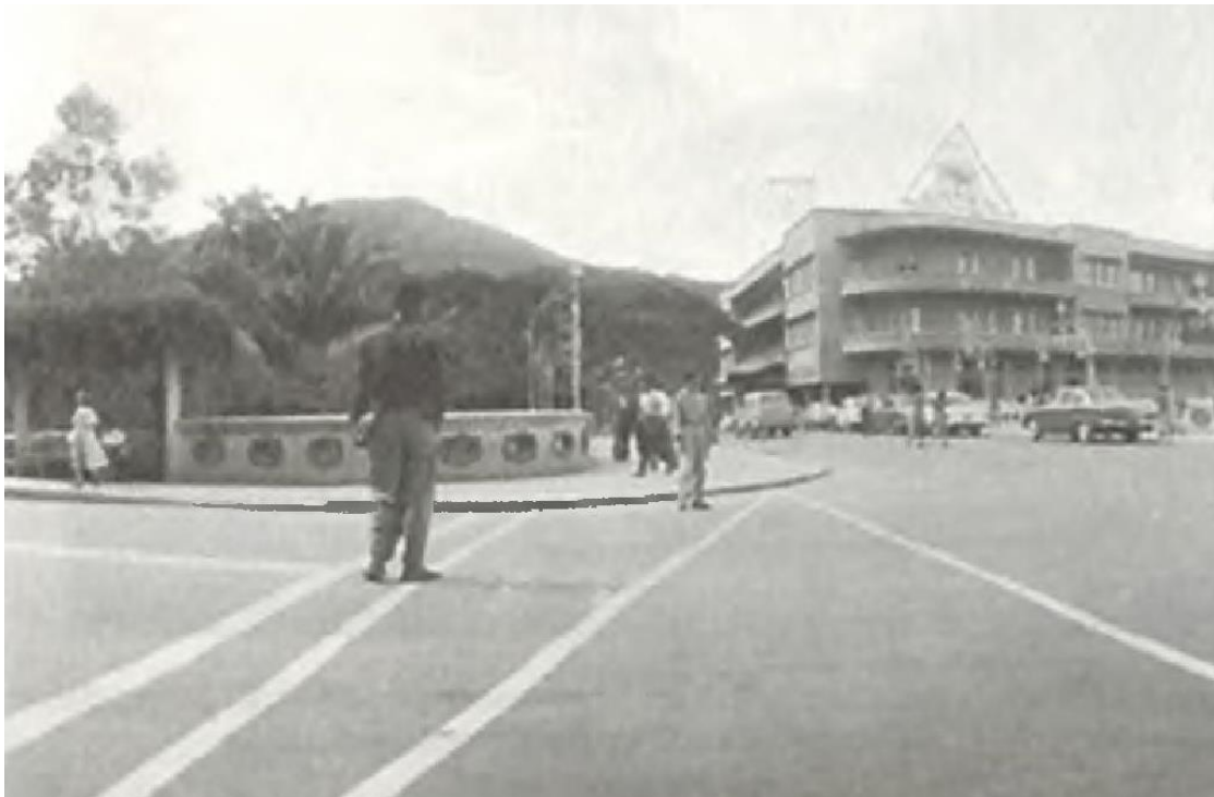
Ilustración 38: Unidad formal del pavimento del puente Ortiz y sus áreas aledañas en 1960.
