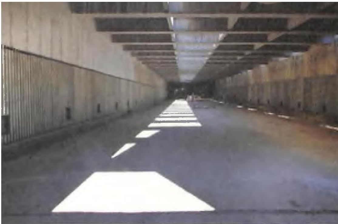
Ilustración 42: Vista del interior del box coulvert bajo la avenida Colombia.
