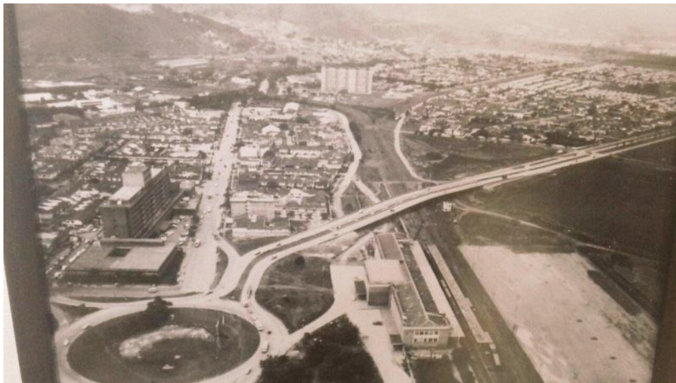
Ilustración 1 Glorieta del Seguro Social. al fondo el edificio venezolano. 1979. Santiago de Cali
