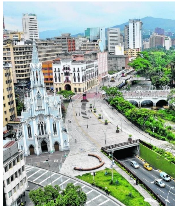
Ilustración 13 : Obra culminada para 2013
