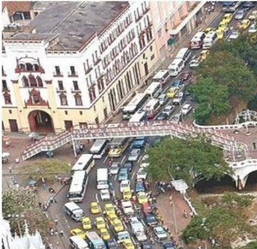
Ilustración 18: Puente peatonal avenida del río
