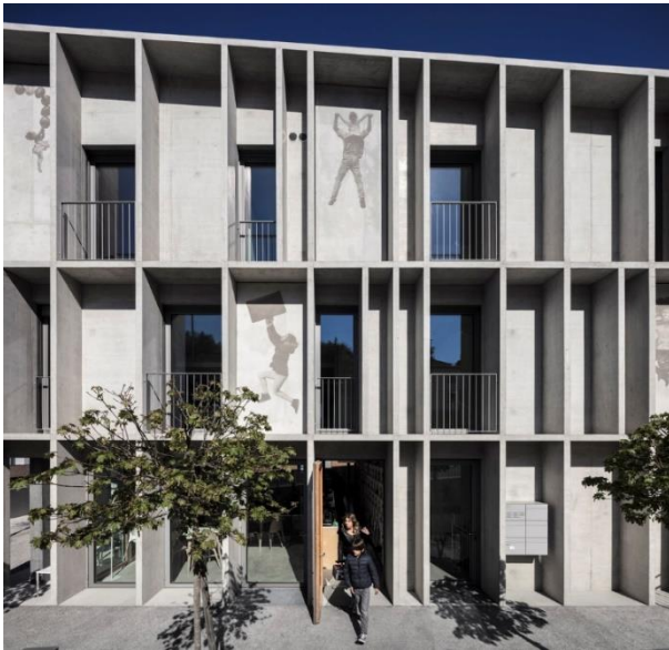
Ilustración 10 37 Edificio Educativo Torre D'Angolo Fuente. (Vergara, 2019)
