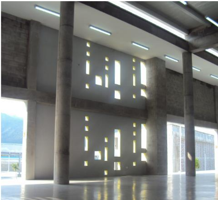
Ilustración 24. Detalle interior 2 Mega Colegio La Ceibita Fuente: (Concha, 2011)
