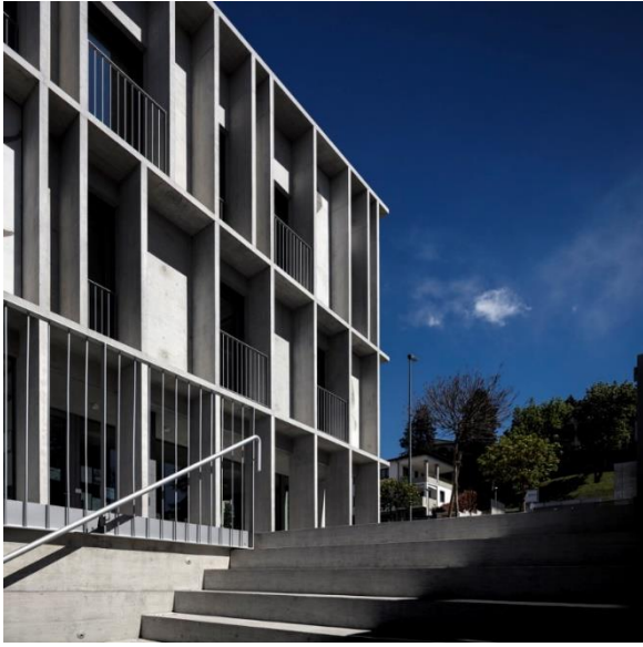
Ilustración 9 Edificio Educativo Torre D'Angolo Fuente. (Vergara, 2019)
