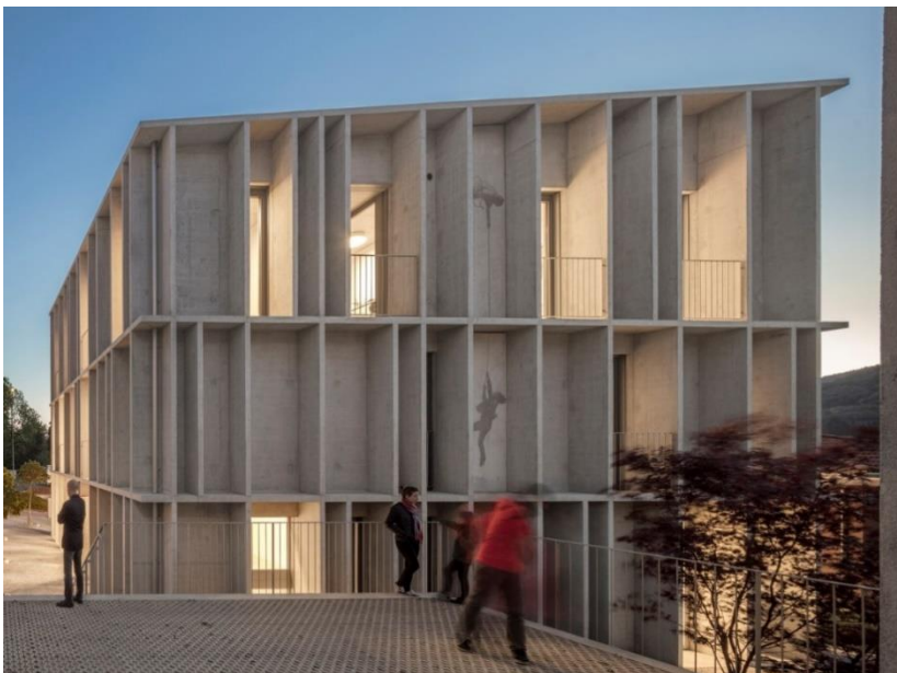
Ilustración 8 Edificio Educativo Torre D'Angolo Fuente. (Vergara, 2019)
