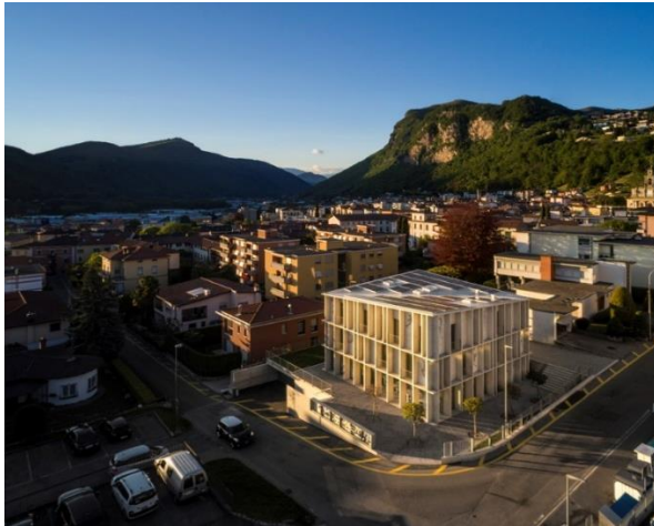
Ilustración 12 Edificio Educativo Torre D'Angolo Fuente. (Vergara, 2019)
