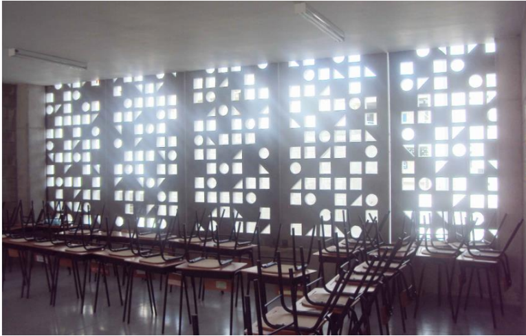
Ilustración 23. Detalle interior 1 Mega Colegio La Ceibita. Fuente: (Concha, 2011)
