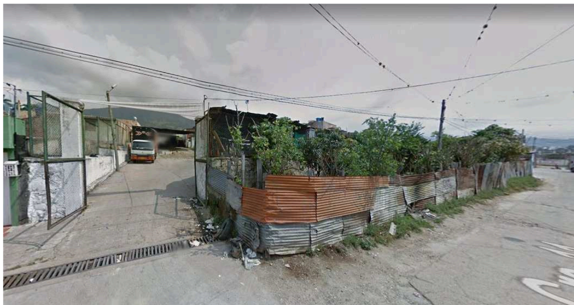
Imagen 3. Acceso principal Plaza de mercado Satélite sobre la carrera 10. Fuente: Google maps, 2018. Recuperada: 12/05/2020
